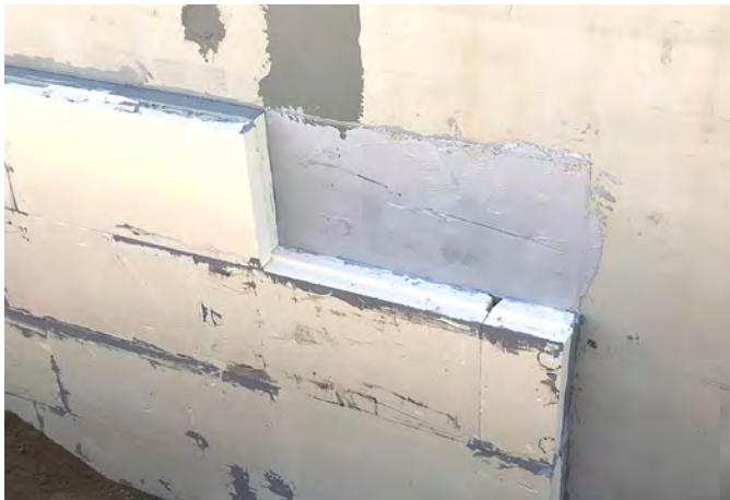
Abb. 04: Vollflächig aufgebrachte Klebermasse auf der Kelleraußenwand
