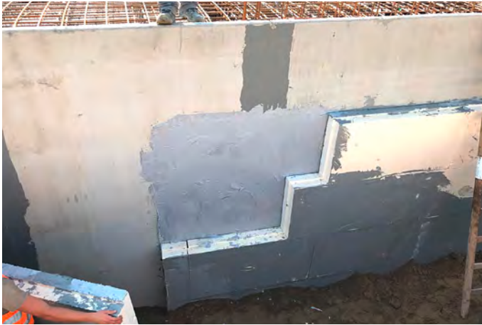
Abb. 05: Ansetzen einer rückseitig mit Klebermasse versehenen Dämmplatte
