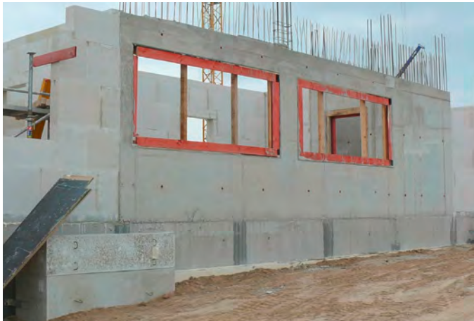
Abb. 01: Blick auf den Rohbau mit verfüllter Baugrube und teilweise sichtbarer Perimeterdämmung
