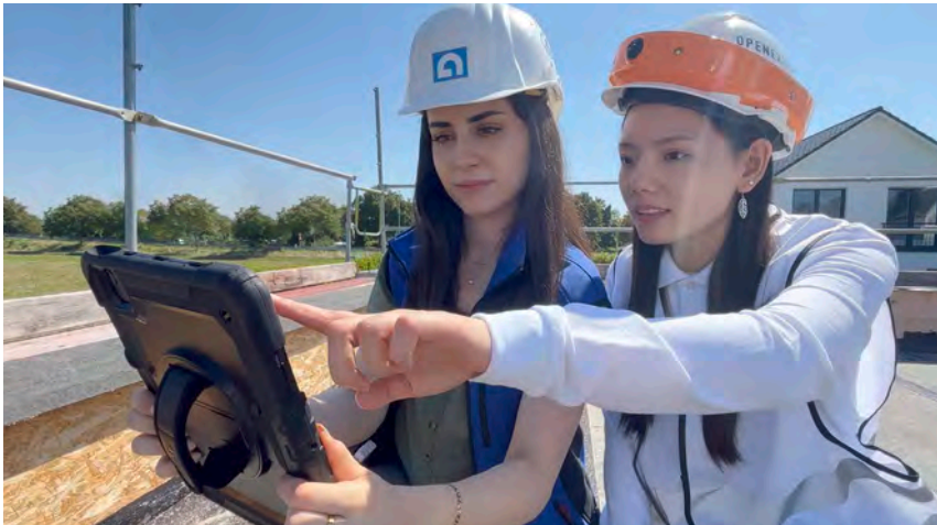
Abb. 03: Einsatz der DIGIBAU 360 auf einer Baustelle [Foto: Open Experience GmbH]
