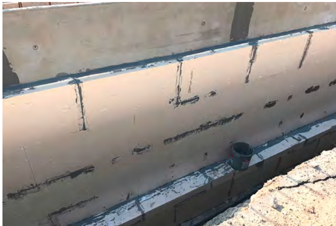
Abb. 06: Neu hergestellte, vollflächige Verklebung der Perimeterdämmung
