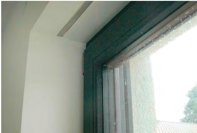
Abb. 01: Neu eingebautes Fenster mit Dreifachverglasung
