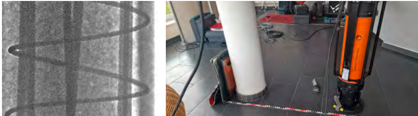
Abb. 12: Visualisierung der Wendel- und Vertikalbewehrung in einer Rundstütze per Radiographie (Röntgen) [Quelle: Dr.-Ing. Sebastian Schulze, bauray GmbH]
