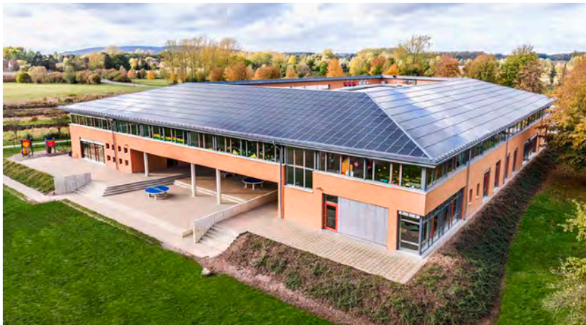
Abb. 01: Fertiggestellte Indach-PV-Anlage auf der Grundschule Gronau (Plusenergie-Neubau, Fertigstellung 04/2012) [Foto: Marvin Rust, rust media solutions]
