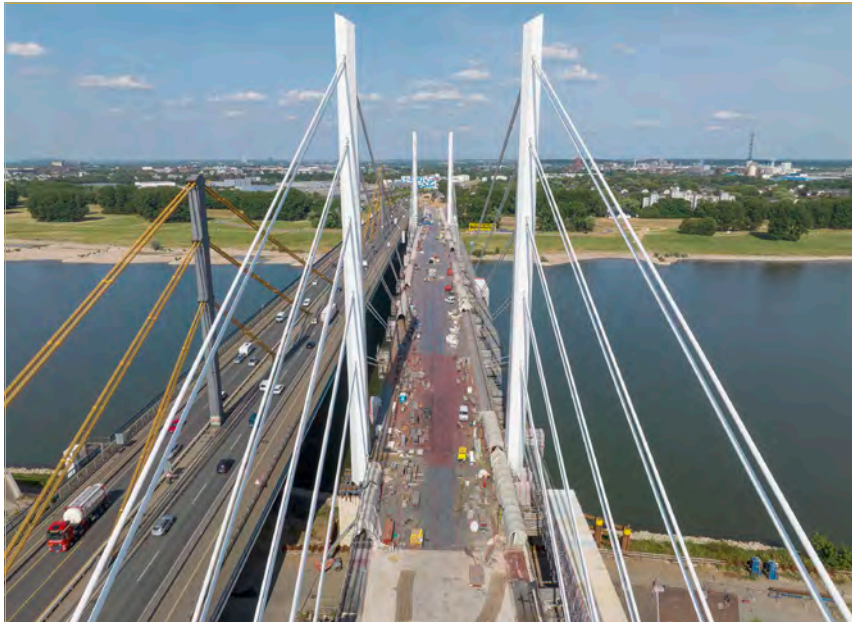
Abb. 01: Brückenbaustelle der Rhein-Brücke Duisburg-Neuenkamp [Foto: Udo Görisch, Take it Media]
