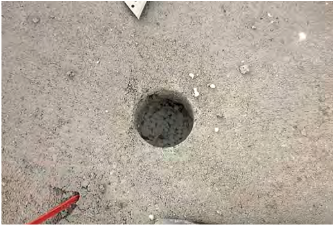
Abb. 04: Bohrung im Fußbodenaufbau für Probenahme
