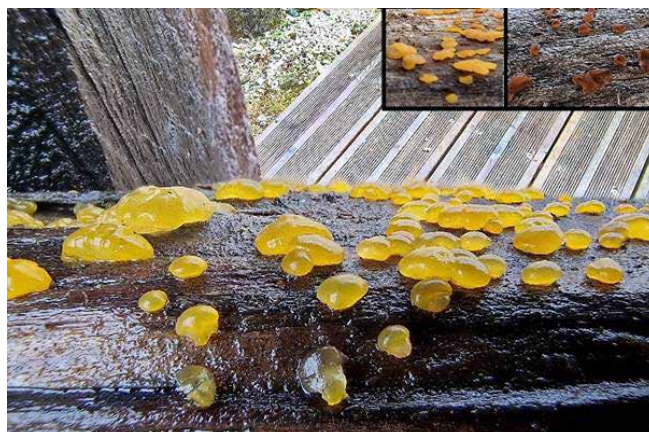
Abb. 1: Indikatorpilz Zerfließende Gallerträne ( Dacrymyces stillatus ): Das Wachstum von Gallertränen zeigt das Fehlen eines ausreichenden baulichen Holzschutzes an, da sie an voll bewittertem Holz wachsen. Fruchtkörper an einer Sitzgelegenheit mit Braunfäule nach einem Regentag; oft scheint das Schadbild zu stagnieren, da die Fäule sehr langsam fortschreitet; Befall von Splintholz; Eckbild: alte, eingetrocknete, braune, hornähnliche Fruchtkörper.
