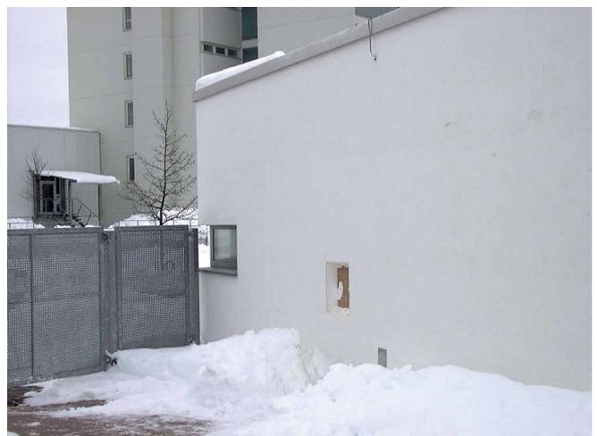
Abb. 1: Schnee vor der Hauswand, deutlich höher als der Sockelputz mit 30 cm Höhe
