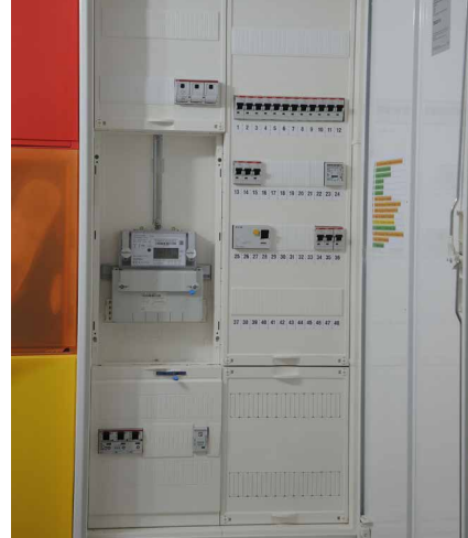
Abb. 5: Ein moderner elektronischer Haushaltszähler »eHZ« kann auch nicht mehr und ist für sich allein noch lange kein »Smart Meter« (siehe Abschnitt 9: »Digitalisierung«)
