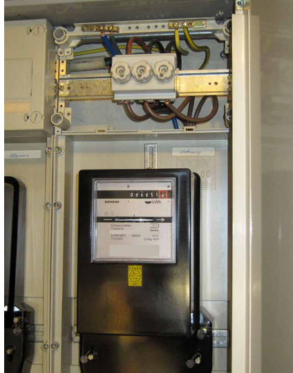
Abb. 4: Noch weit verbreiteter traditioneller »Ferraris-Zähler«
