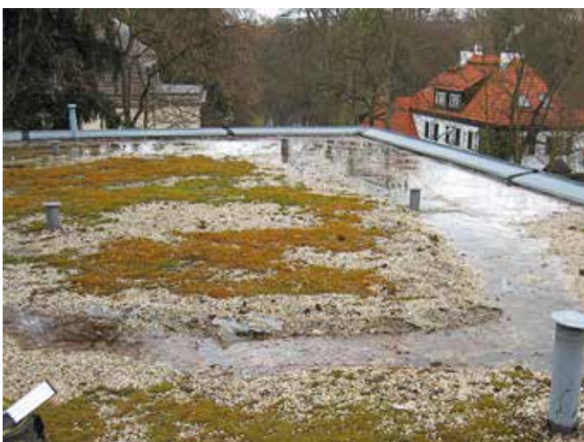
Abb. 9: Nicht genutztes, extensiv begrüntes Dach mit Pfützenbildung (© T. Platts)
