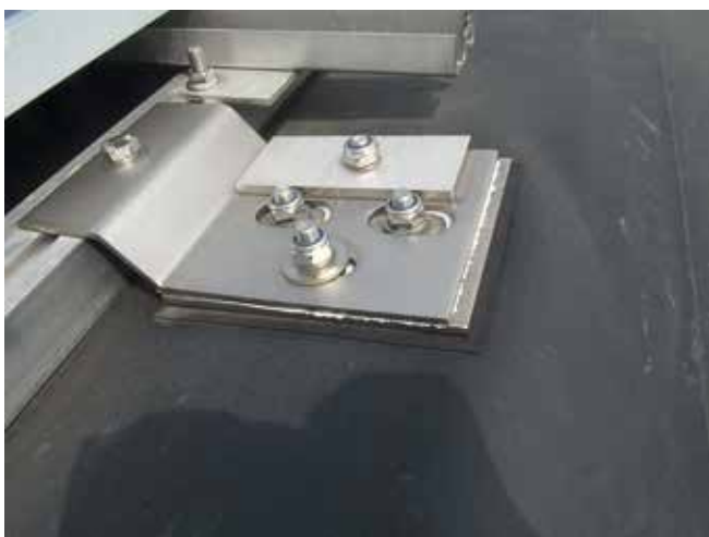
Abb. 12: Fachgerechte Ausführung einer Windsogsicherung mit einer ausreichend dimensionierten Los-Festflansch-Konstruktion bei Dachabdichtung mit Kunststoffbahnen (© T. Platts)
