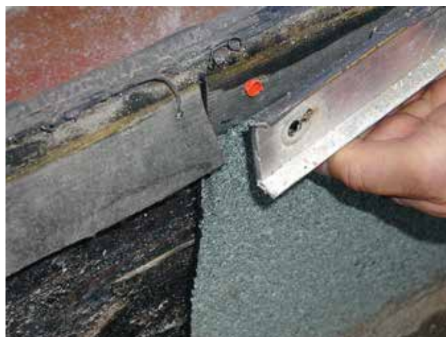
Abb. 15: Praxisbeispiel mit der die beiden Bitumenbahnen überdeckenden 1,2 mm dicken EPDM-Bahn (© H.-H. Wetzel)
