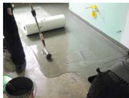
Abb. 54: Einbau einer vliesarmierten, systembedingt 2,0 mm dicken Reaktionsharzabdichtung in einem Wohnbads mit bodengleicher Dusche
