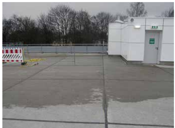
Abb. 37: Parkdach kurz vor Fertigstellung der Sanierungsarbeiten
