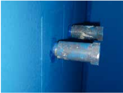
Abb. 60: Beispiel einer normgerechten Dichtmanschette für eine Rohrdurchdringung
