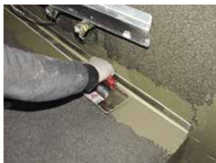
Abb. 58: Wie Abb. 57, jedoch nach Teileinbettung in den Dünnbettmörtel
