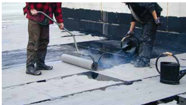
Abb. 31: Einbau einer Polymerbitumen-Dichtungsbahn mit Polymerbitumen-Klebmasse im Gießverfahren auf dem Parkdach (Umkehrdach) eines Möbelhauses
