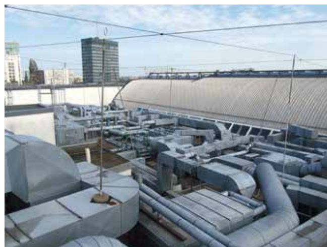
Abb. 4: Genutztes Dach mit haustechnischen Anlagen (© T. Platts)
