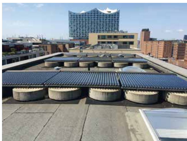
Abb. 3: Genutztes Dach mit ballastierten Solaranlagen (© T. Platts)
