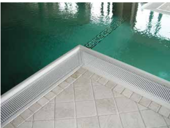
Abb. 68: Beckenkopf mit hochliegendem Wasserspiegel, System »Wiesbaden«
