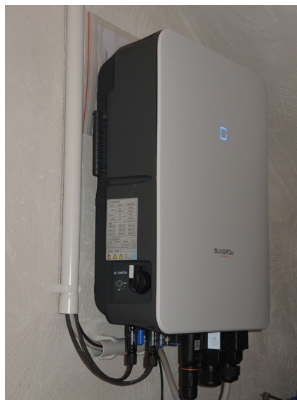
Abb. 20: Im Wechselrichter ist gleich ein »Smart Meter« mit eingebaut, wie man an den kleinschrittig gespeicherten Daten erkennt
