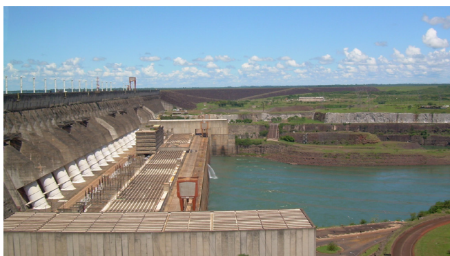
Abb. 22: Gesamtansicht der 20 Blöcke von Itaipú [23]
