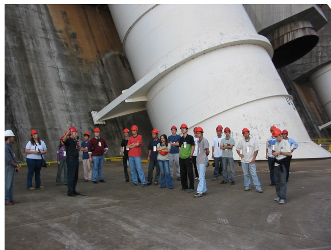
Abb. 23: Jedes einzelne Rohr hat einen Innen-Durchmesser von 10,5 m und führt einen Bemessungswasserstrom von 700 m³/s! [23]
